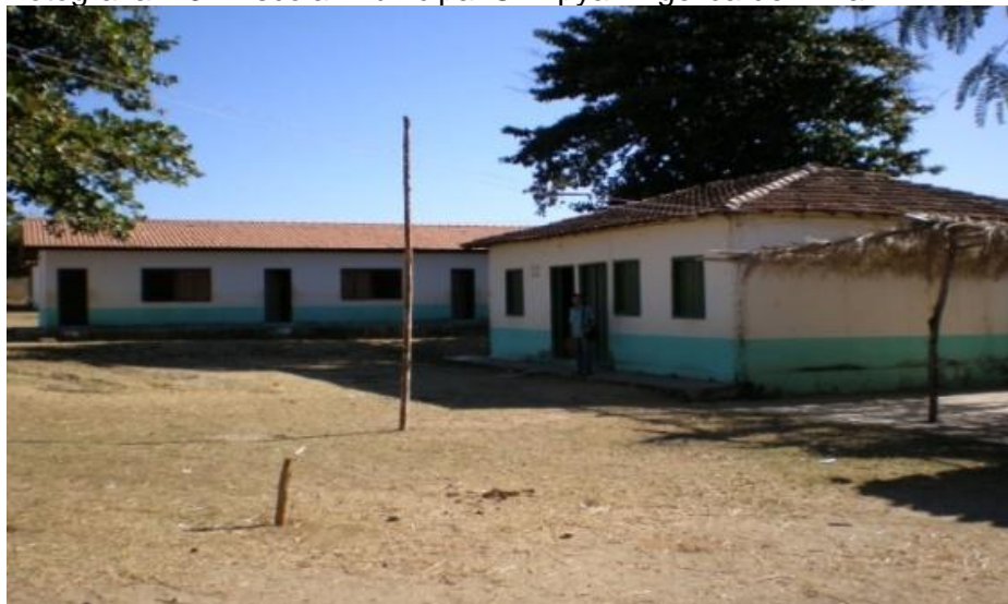
Fotografia 13 - Escola Municipal Olímpya Angelica de Lima
