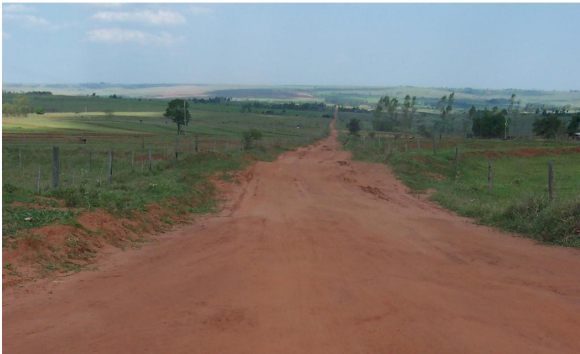
FIGURA 17.- VISTA PARCIAL DEL SECTOR II DEL ASENTAMIENTO SÃO BENTO
