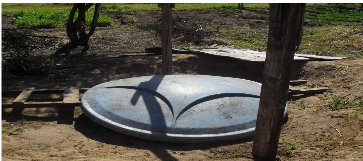
Foto 6 - Poço para captação d'água no acampamento Palmares, município de Araçatuba
